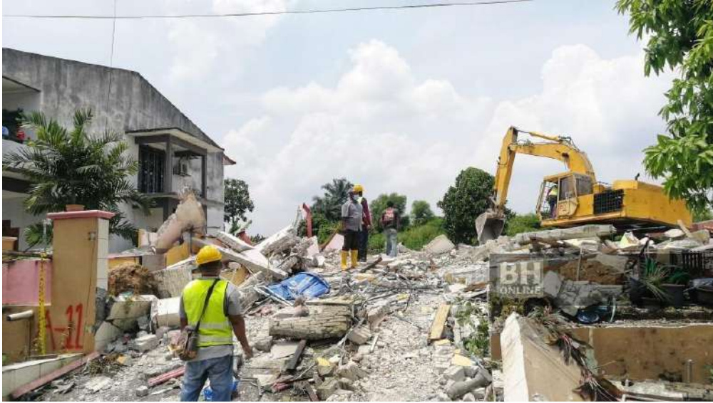
Jentolak merobohkan perumahan penduduk yang dibina di tepi sungai di Kampung Sungai Pelepas di Desa Subang Perantau, Shah Alam. - NSTP/Mahzir Mat Isa
